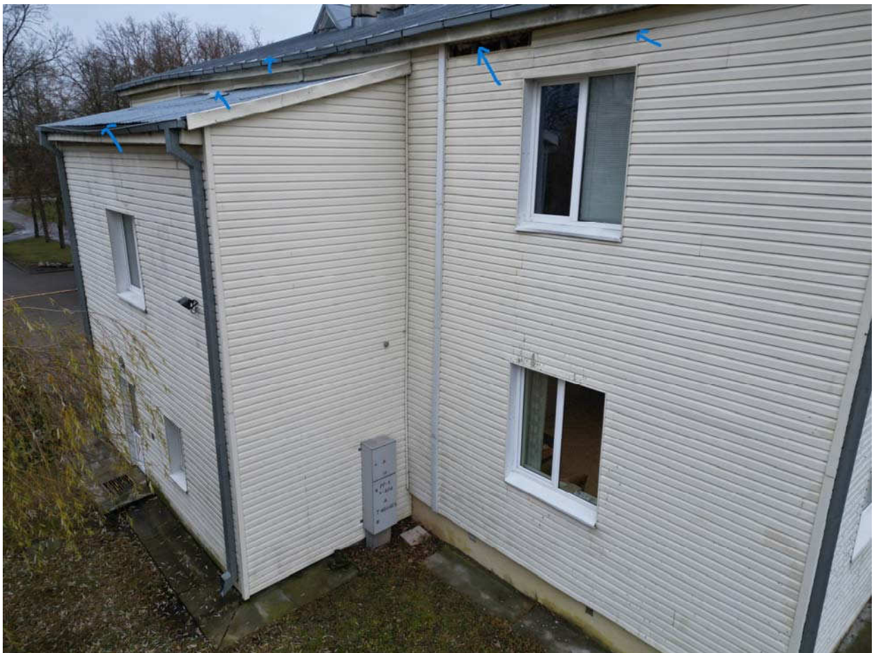
06 pav. Defektų pietiniame fasade fotografacija
