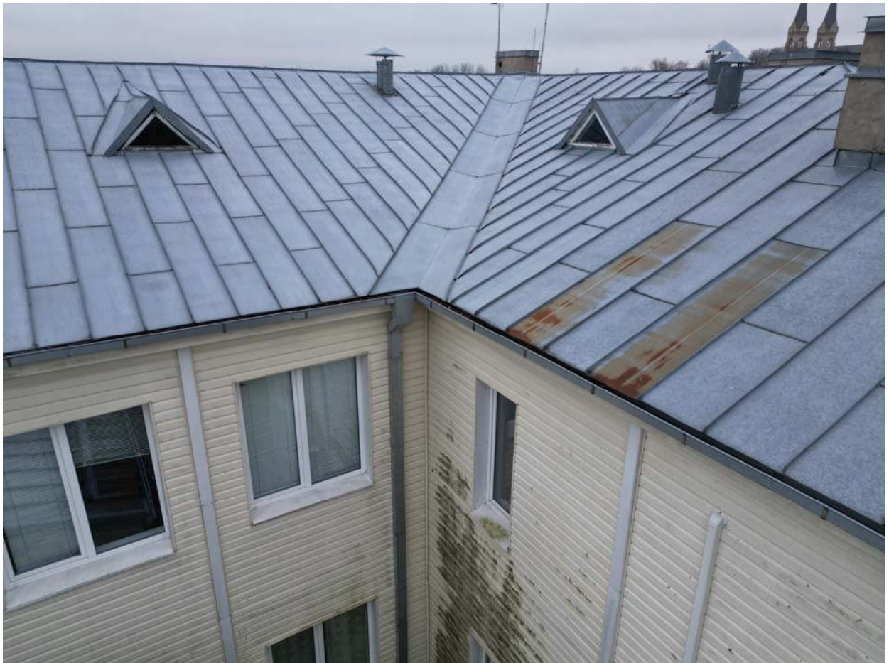
08 pav. Fasado ir stogo projektuojamo keltuvo zonoje fotofiksacija
