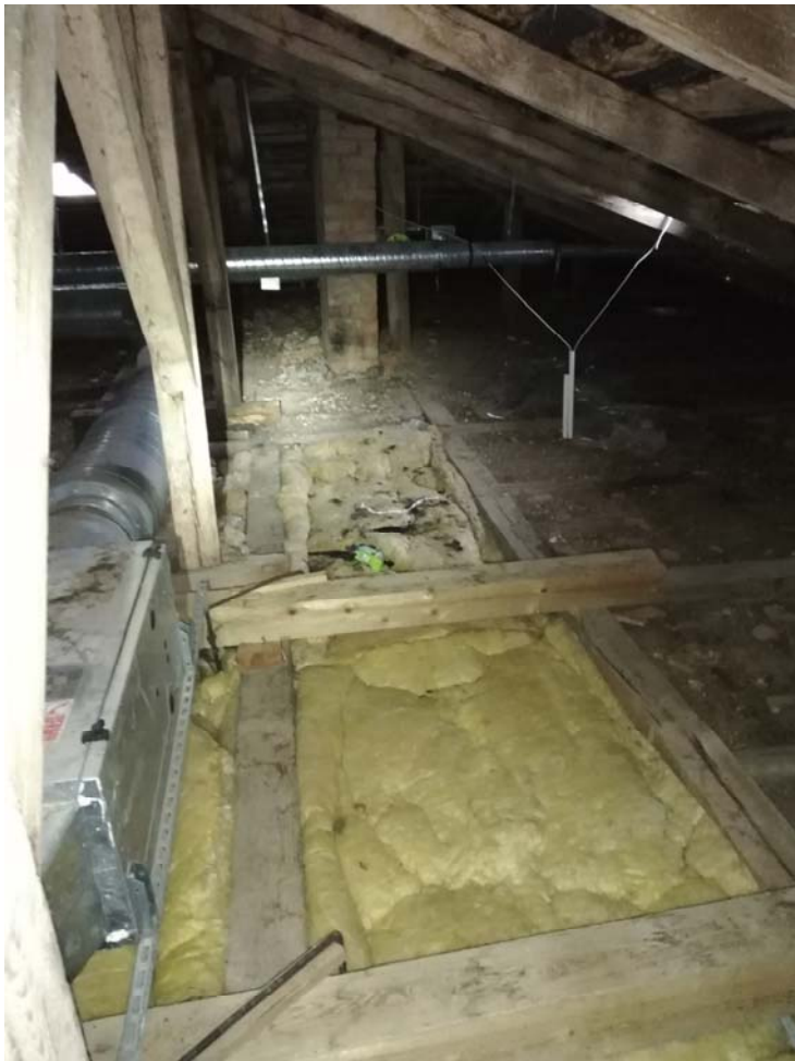
18 pav. Ila. perdangos konstrukcijų (virš patalpos inv. Nr. 2-14) fotofiksacija
