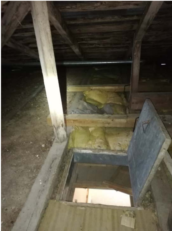
16 pav. Ila. perdangos konstrukcijų ties liuku (virš patalpos inv. Nr. 2-6) fotofiksacija
