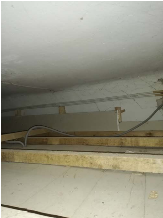
30 pav. Rekonstravimo metu pertvaros ir sienos apdailintos g/k plokštėmis ant medinio karkaso. Žemiau IIa. perdangos (30-40cm) įrengtos pakabinamos g/k plokščių ant medinio karkaso pakabinamos lubos.
