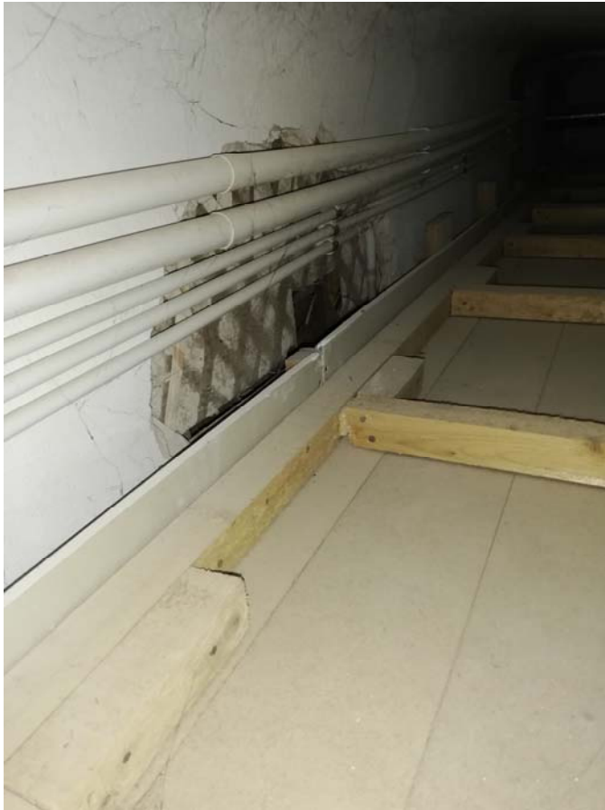
27 pav. Rekonstravimo metu pertvaros ir sienos apdailintos g/k plokštėmis ant medinio karkaso. Žemiau IIa. perdangos (30-40cm) įrengtos pakabinamos g/k plokščių ant medinio karkaso pakabinamos lubos.
