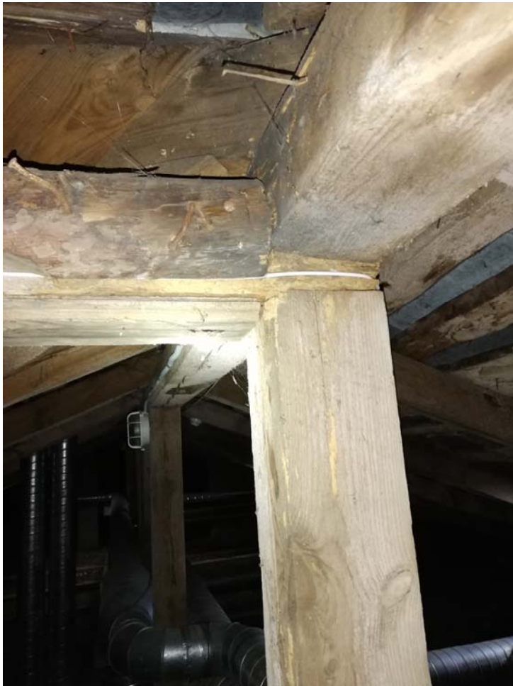
20 pav. Stogo konstrukcijos (virš patalpos inv. Nr. 2-15) pažeistos biologinių kenkėjų
