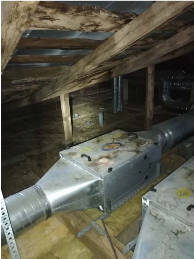
17 pav. Ila. perdangos konstrukcijų (virš patalpos inv. Nr. 2-14) fotofiksacija
