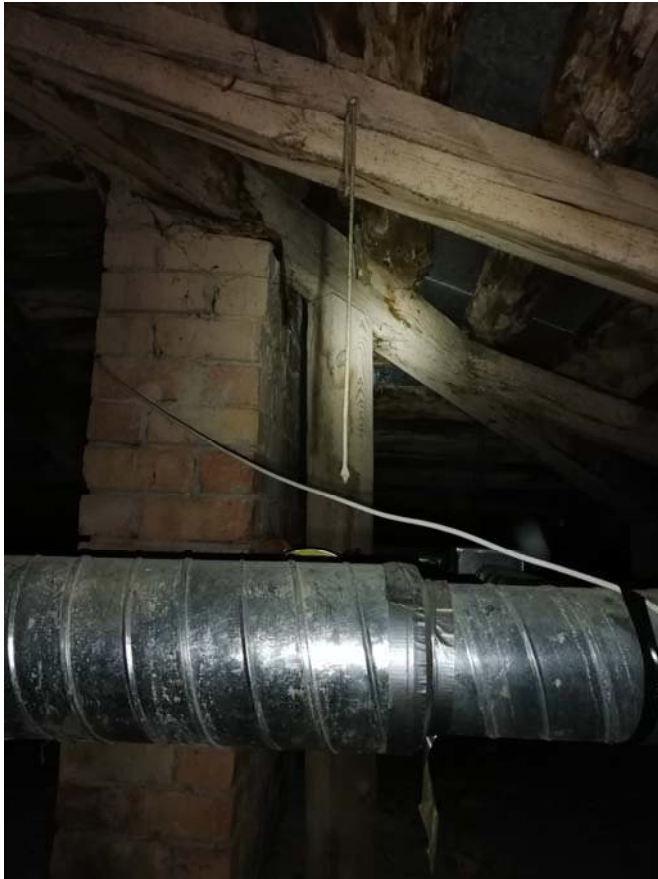
23 pav. Valminės stogo sijos atrėmimas į kaminą ir laikinčiąją sieną virš patalpos inv. Nr. 2-26
