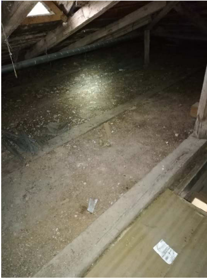
15 pav. Ila. perdangos konstrukcijų ties liuku (virš patalpos inv. Nr. 2-6) fotofiksacija
